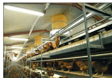
KØLING: Rotor A/S har udviklet et ligetryksanlæg til hønsesalder, hvor temperaturen kan styres jævnt i hele stalden, hvor dyrene står tæt.
